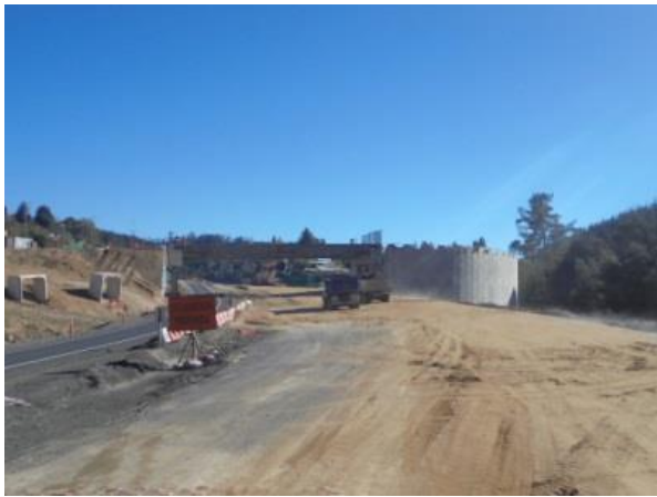
Muro TEM y Estructura Paso Inferior El Pino, Dm. 58.450, Sector A
