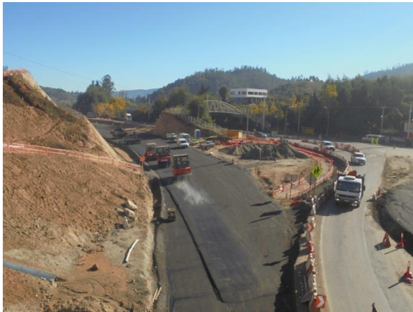
Colocación Pavimento Asfáltico Enlace Agua de la Gloria, Dm. 60.000, Sector A
