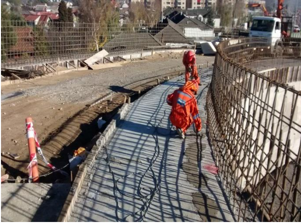
Enfierradura Defensas Tipo F, Paso Inferior Retorno Collao, Dm. 71.400, Sector A
